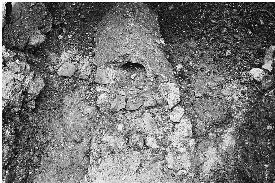
Εικ. 13: Αγωγός πλησίον του κρηναίου, αρχείο ΕΦΑΚΕΦΙ
