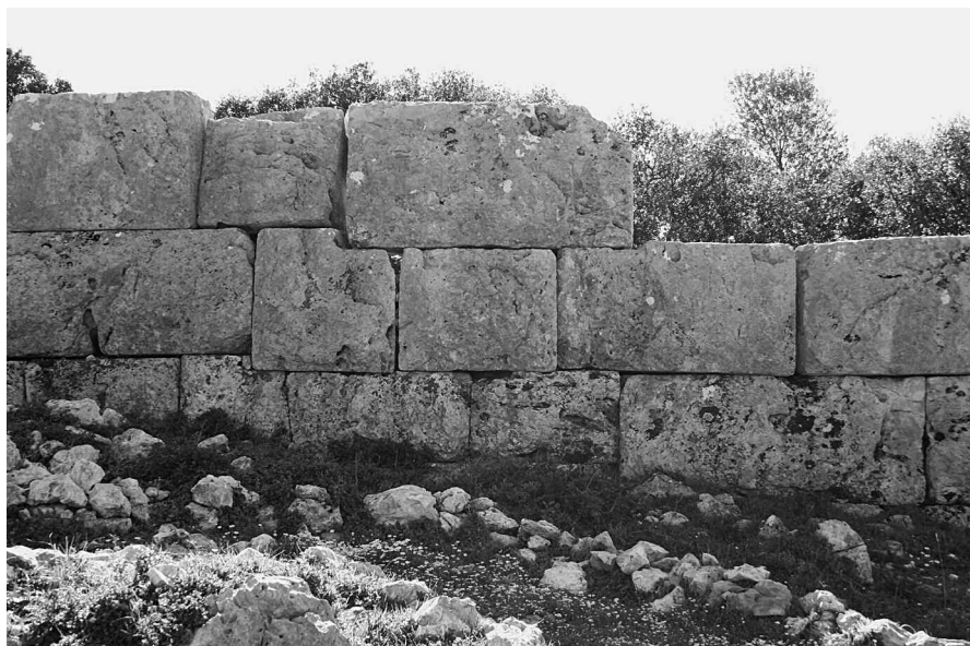
Εικ. 21. Η όψη του τραπεζιόσχημου συστήματος δόμησης
