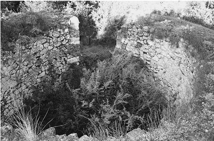
Εικ. 55. Μερική άποψη ασβεστοκάμινου
