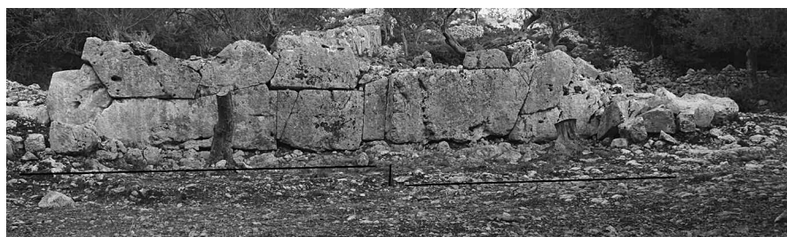
Εικ. 27. Ο Π.12 και άποψη του τείχους
