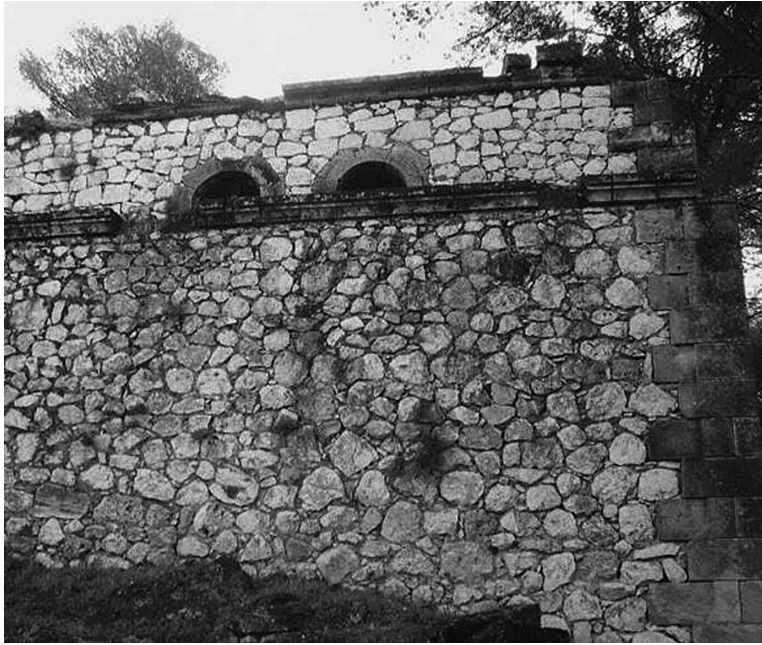
Εικ. 52. Μερική άποψη του υδραγωγείου
