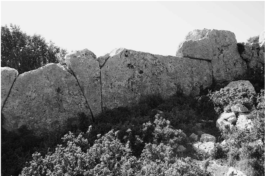
Εικ. 20. Όψη πολυγωνικού συστήματος δόμησης
